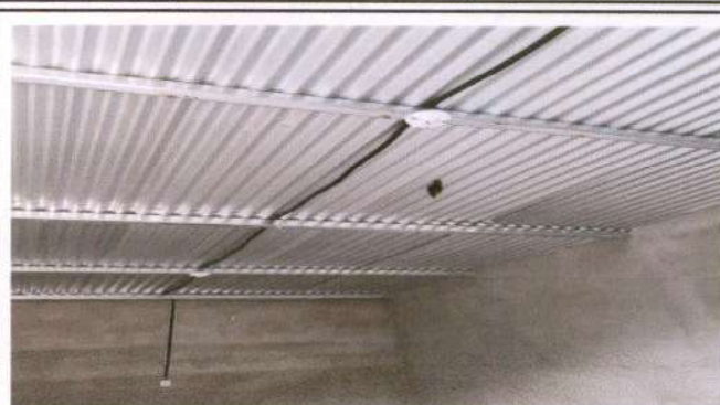
Instalación de unidades de luz, (incluye interruptor, ducto y cable electrico)
