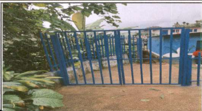
Fabricación e instalación de portón de ingreso
