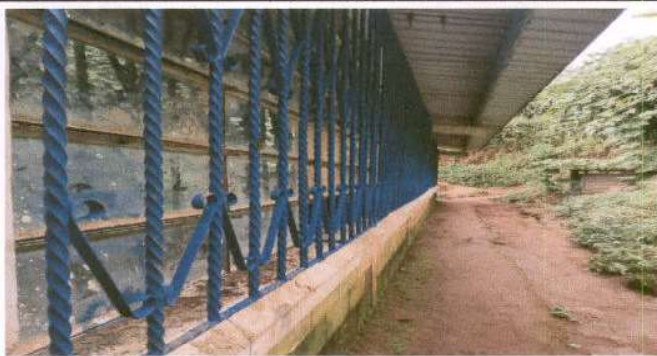
Mantenimiento a balcones de metal
