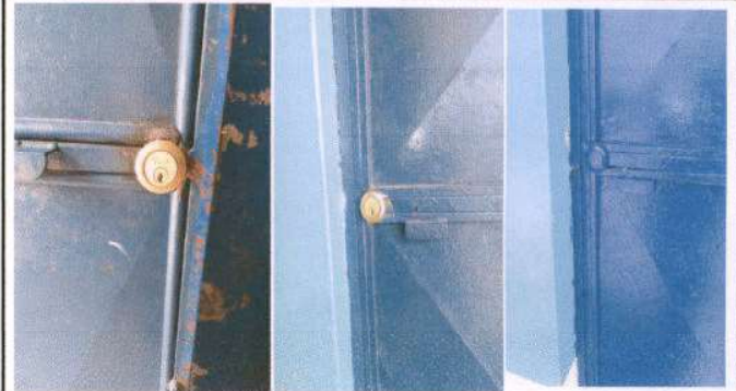
Mantenimiento a estructura (Lijado, cambio de tubo, cepillado, sujeciones aplicación de Pintura) y sustitución de Chapa
