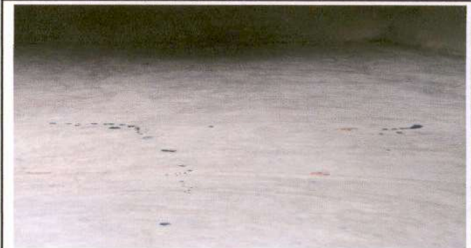
Sustitucion de Piso de Geranito
